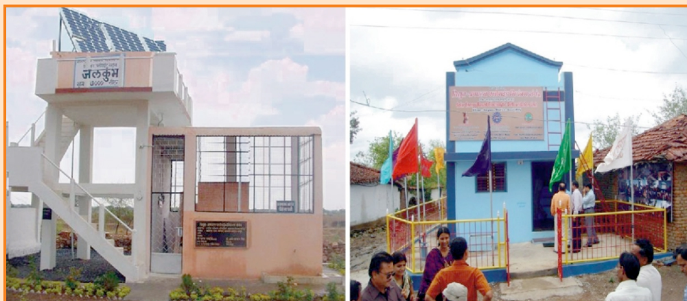
सीएसआईआर- नीरी द्वारा विकसित इलेक्ट्रोलिटिक डिफ्लोरिडेशन संयंत्र।
