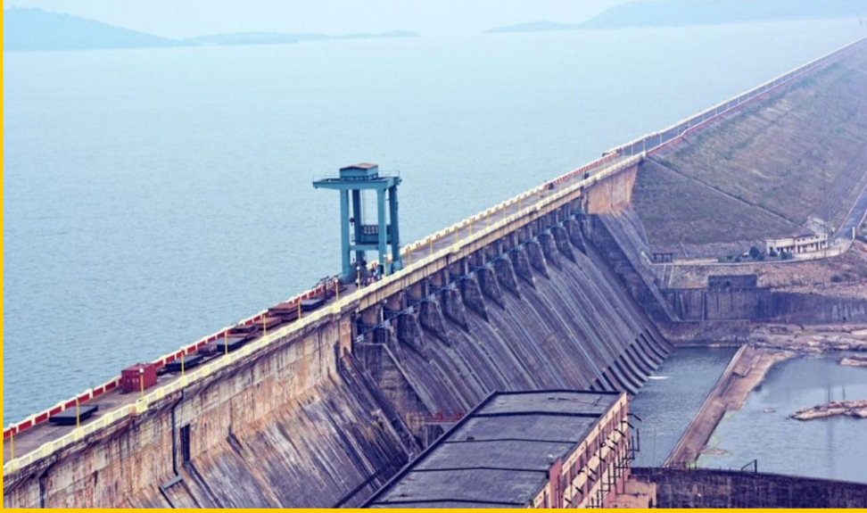
देश की प्रथम बहुउद्देशीय परियोजनाओं में से एक है। उड़ीसा के सम्बलपुर के पास महानदी पर बना देश का सबसे लंबा (25.8 किलोमीटर) मिट्टी का बांध, हीराकुंड।
